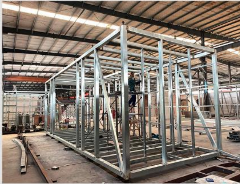
Estructura de acero galvanizado en caliente
